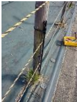
鉄パイプで補強をしハガネで固定
