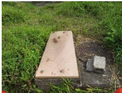
新たにコンクリート型枠用合板で蓋を製作
