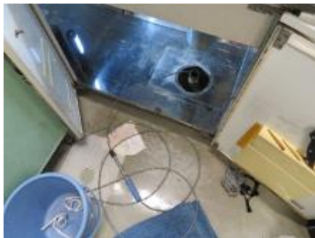
パイプクリーナーにて配管清掃
