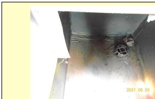
● 清掃後(排水溝の汚れを除去しました)
