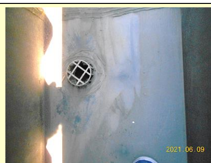
● 清掃後(排水溝の汚れを除去しました)
