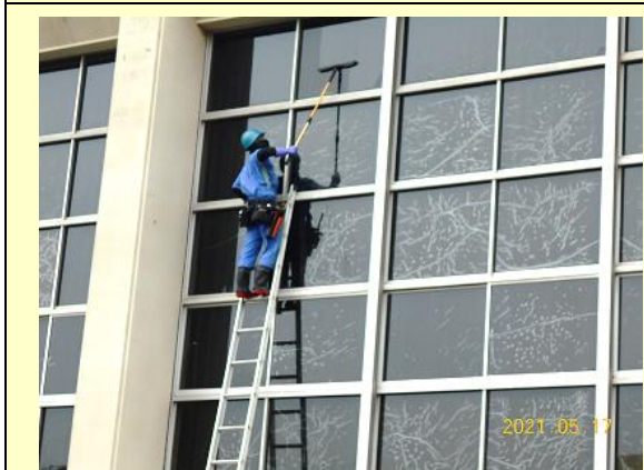
● 窓清掃(1階・体育館外面)
