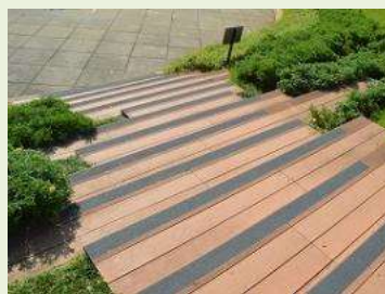
階段部の滑り止め設置
