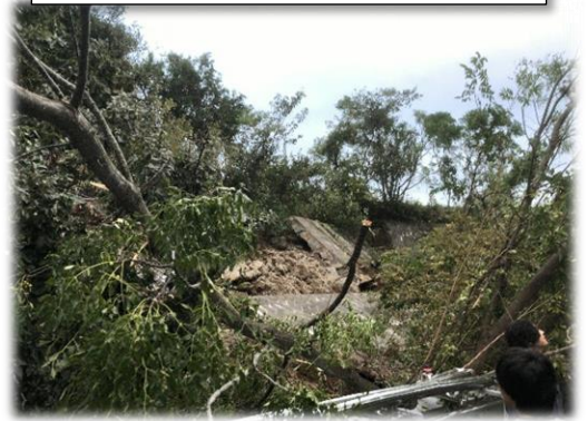
崩れたガーデンセブンの裏の崖
