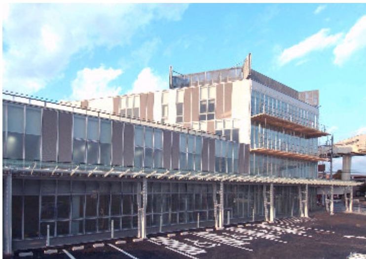
平成17年4月にオープンした若葉保健福祉センター
