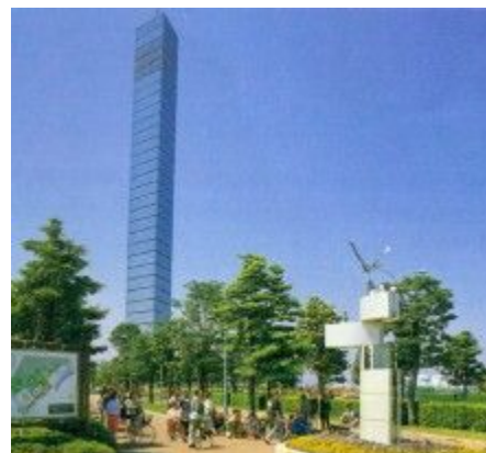
千葉ポートタワー
