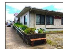
緑道に面した敷地内にベンチを設置
