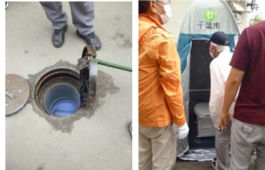
《 マンホールトイレ設置訓練 》
