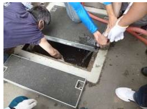
《 マンホールトイレ貯水槽に給水 》
