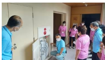
消火栓の使用方法を確認
