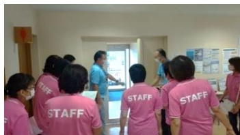
防火扉の動作確認
