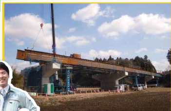
主要地方道 浜野四街道長沼線 (大井戸工区・橋梁架設工事)
