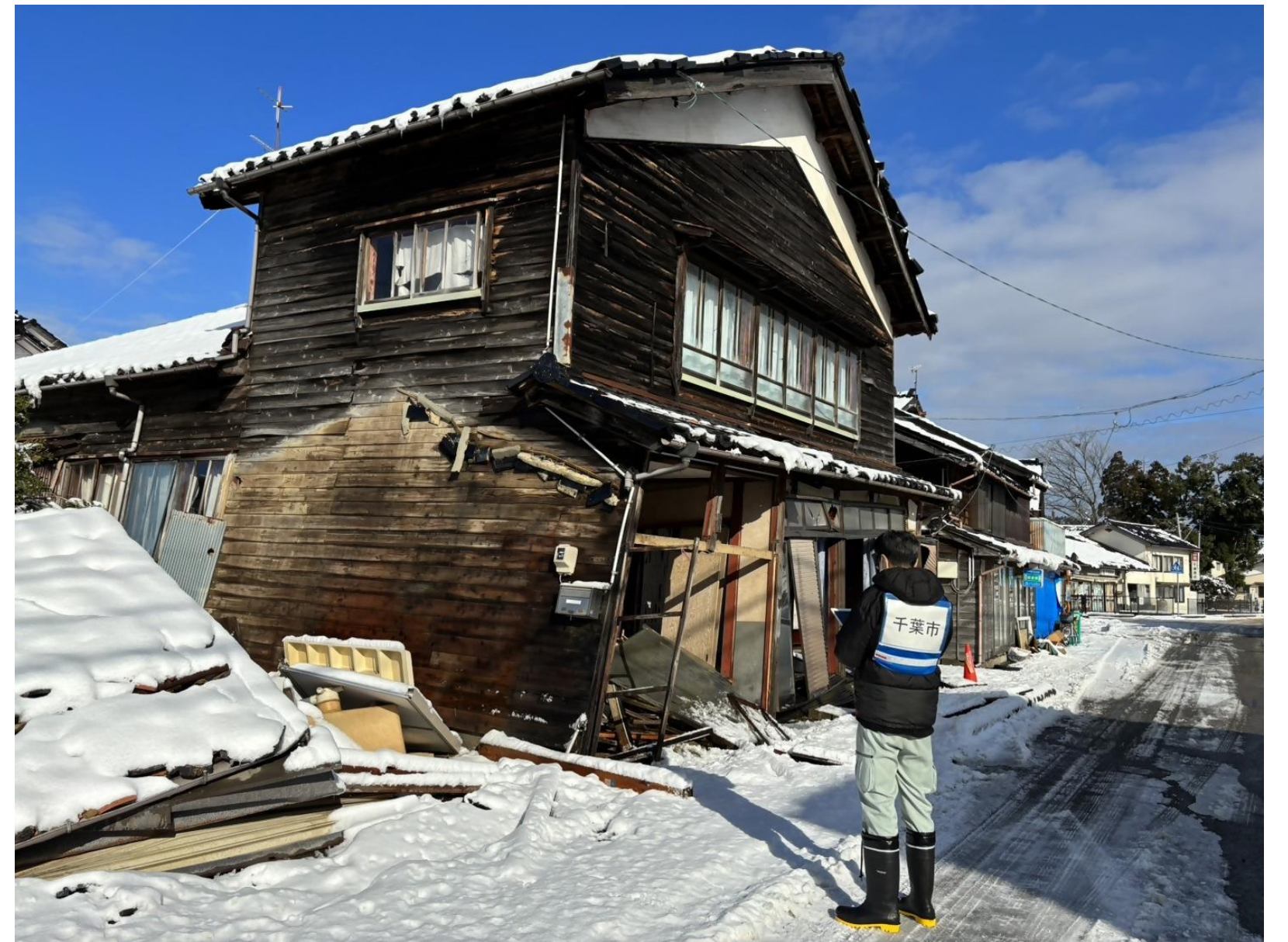
被害認定調査の様子
