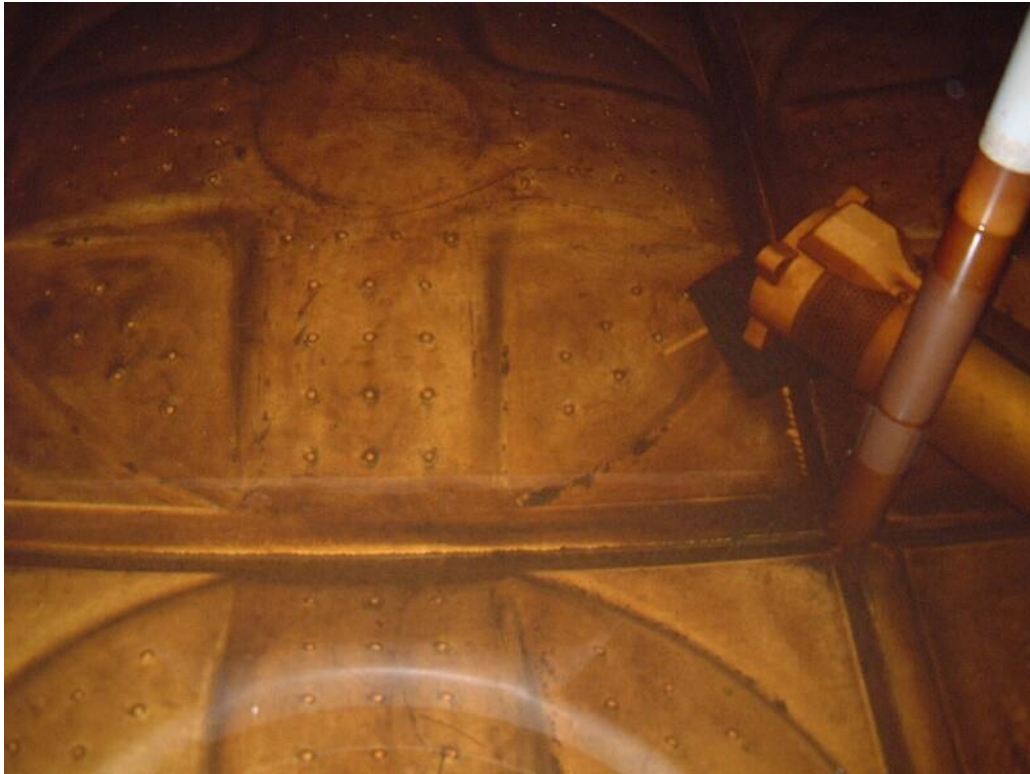
受水槽の内部の写真：清掃前の状態
