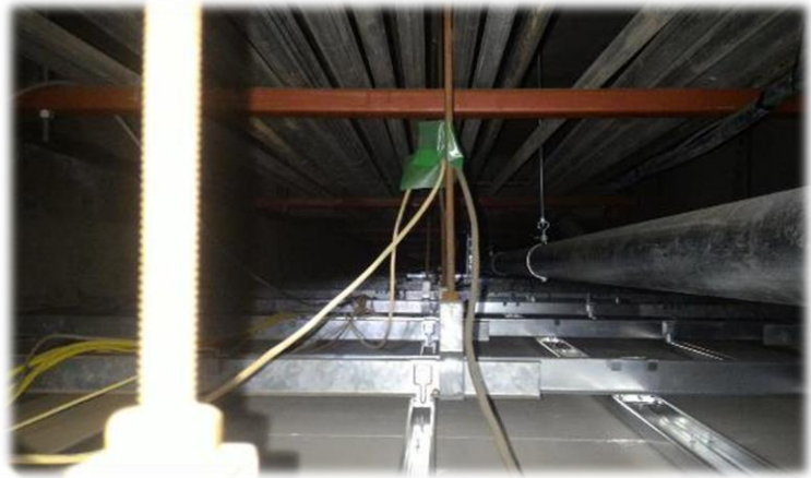
②現地で図面との整合性を確認
