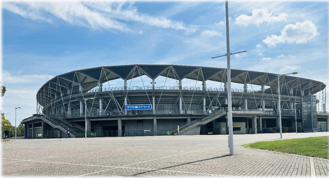
フクダ電子アリーナ (ジェフユナイテッド市原・千葉本拠地) 竣工:平成15年 改修工事
