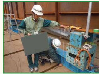
工事現場の様子
