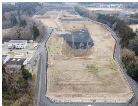
[ 新内陸最終処分場の全景 ]
