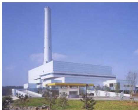
[ 北清掃工場の全景 ]
