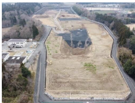
[ 新内陸最終処分場の全景 ]
