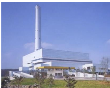
[ 北清掃工場の全景 ]
