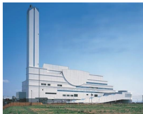
〔 新港清掃工場の全景 〕
