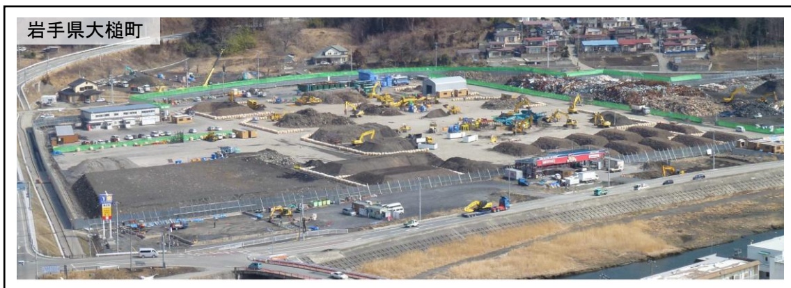
図 3-1-4-1 二次仮置場の例
