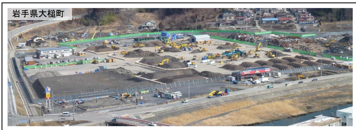
図 3-1-4-1 二次仮置場の例
