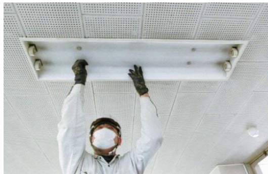
① 蛍光管をはずす。
