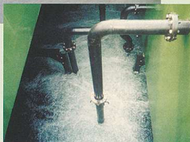
① 生物処理槽 生物処理(接触ばう気法)によって、浸出水中のBOD、COD及び窒素成分を除去します。
