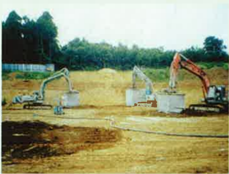
① 浅層混合改良
