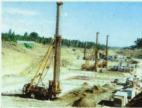
① 深層混合改良
