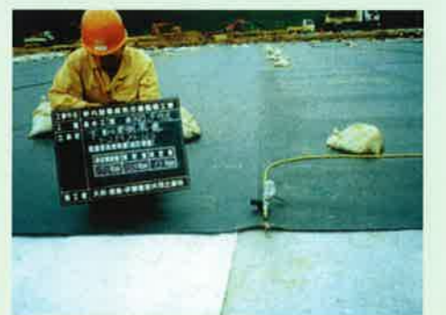
① 遮水シート検査(加圧式)
