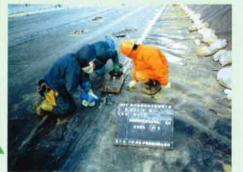
① 遮水シート検査(真空ボックス)
