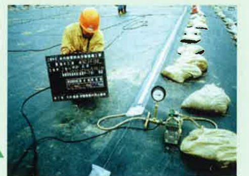
① 遮水シート検査(真空吸引式)
