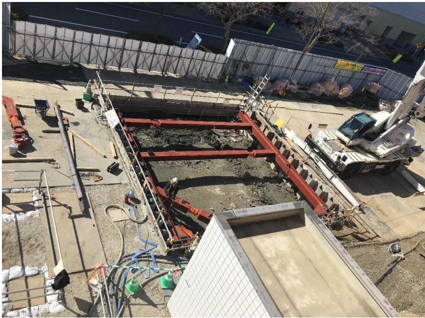
工事名 横浜新都市商業地空輸送システムこみ輸送管理旧業務委託 工種 地盤改良工 測点 地盤改良工 プラント解体状況 JFEエンジニアリング株式会社
