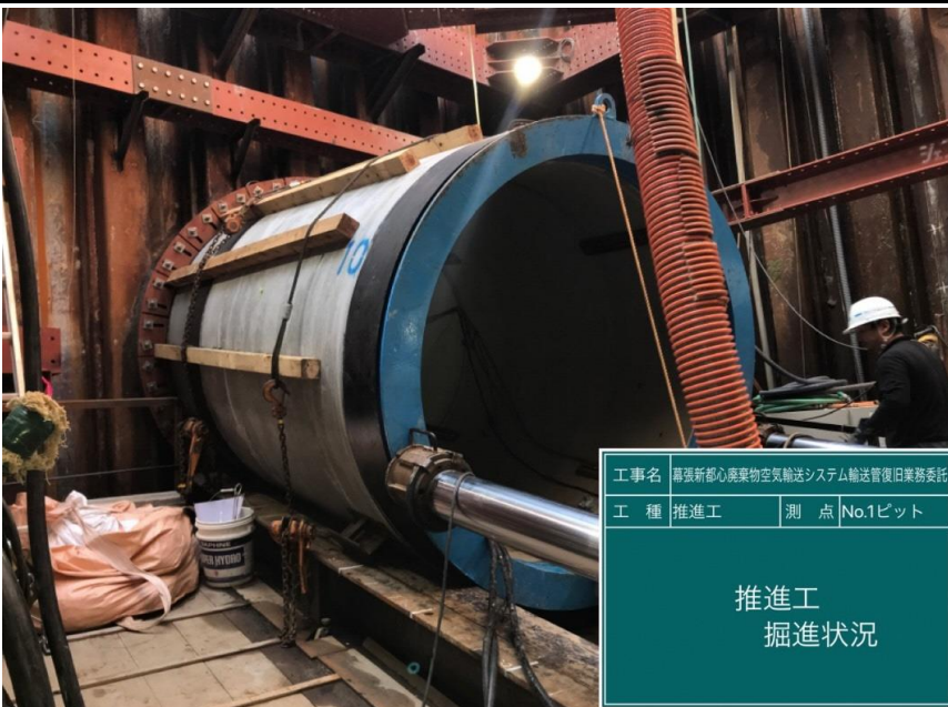
工事名 幕張新都心廃棄物空気輸送システムごみ輸送管復旧業務委託 工種 推進工 測点 No.1ピット 推進管投入 掘付状況 JFEエンジニアリング株式会社
