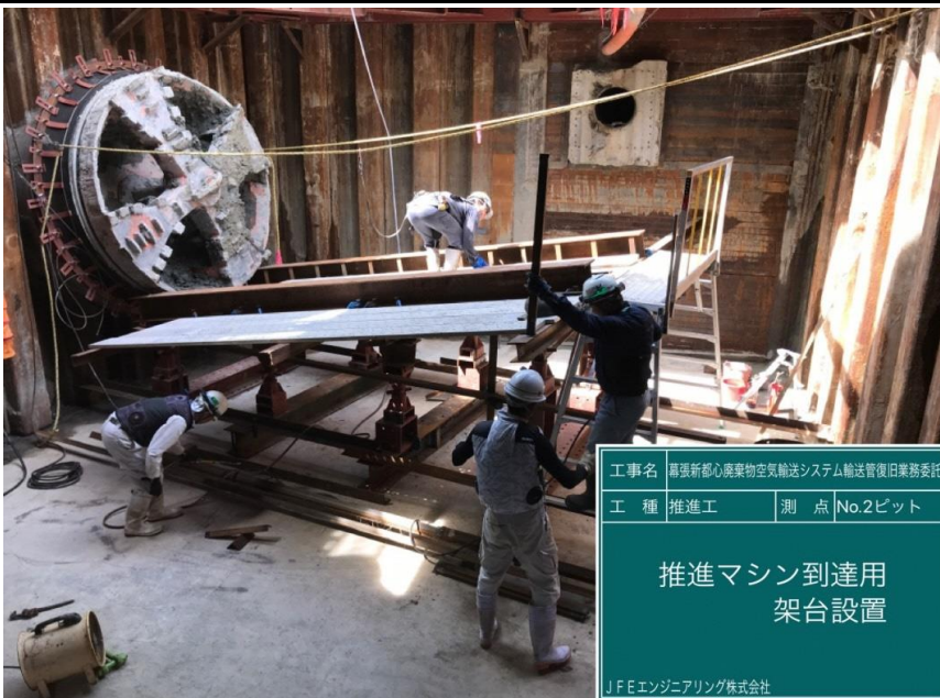
工事名 高張新都心廃棄物空気輸送システム輸送管復旧業務委託 工種 推進工 測点 No.2ピット 推進マシン到達状況
