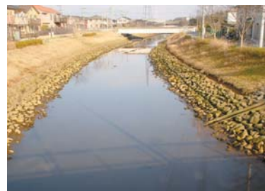
生実川(平成橋付近)
