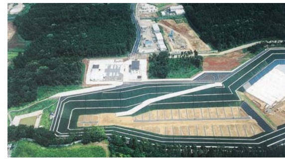
千葉市の埋立場 新内陸最終処分場 埋立容量: 939,000立方メートル 埋立面積: 82,800平方メートル
