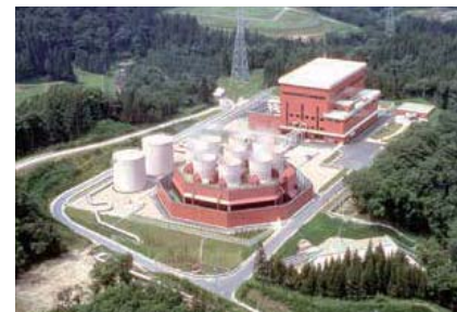
福島県柳津西山地熱発電所
