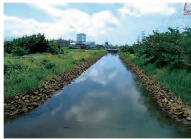
生実川(平成橋付近)
