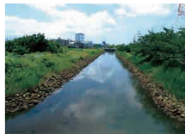
生実川(平成橋付近)
