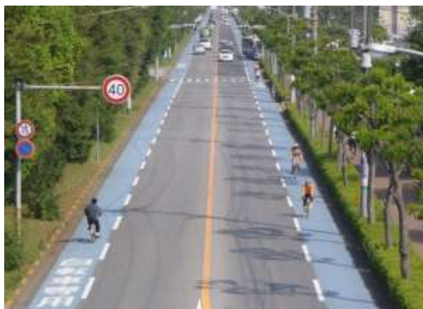
図表 1-5-9 市内の自転車レーン（市道 高洲中央港線（京葉線通り）
