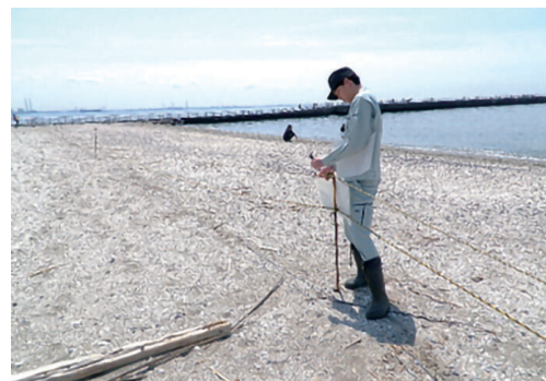
ロープ柵設置の様子
