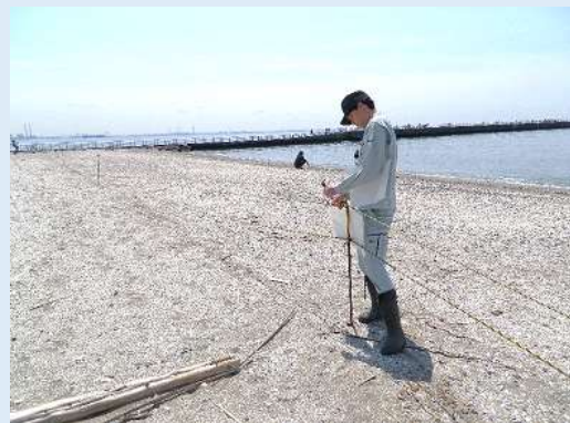
ロープ柵設置の様子
