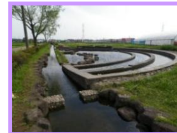
8.水環境施設(杉山地区)
