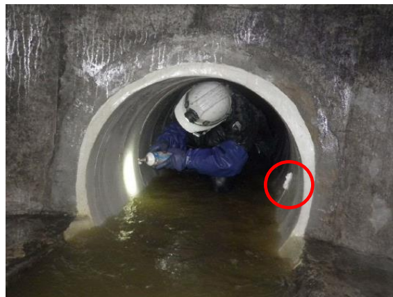
シール材注入状況
