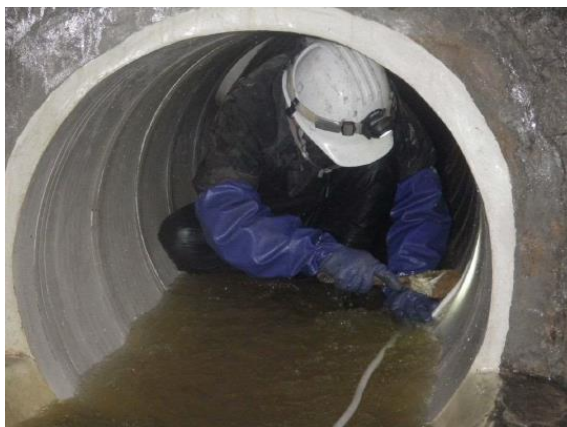
バックアップ材施工状況
