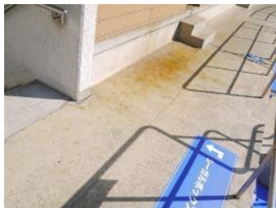
【写真②：通路の錆水による変色】
