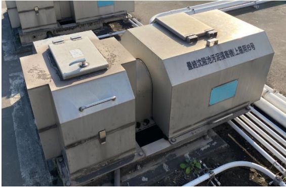
No. 14 最終沈殿池汚泥掻寄機(上層)6号 (令和5年10月12日撮影。以下同じ。)
