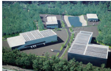
ネクストコア千葉生実 2027(令和9)年の造成工事完了予定。
