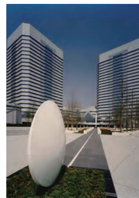
幕張テクノガーデン 1990(平成2)年に開業した、日本初のインテリジェントビル。
