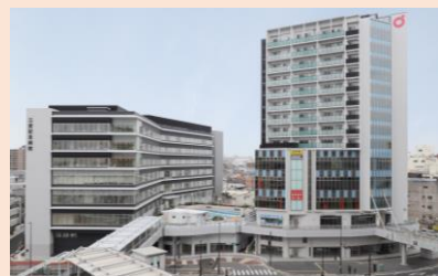
千葉駅西口再開発ビル ウェストゲート千葉
