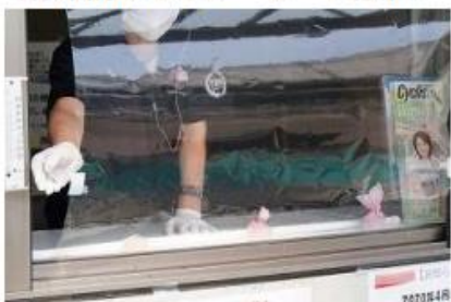
飛沫防止クリアーシート設置
