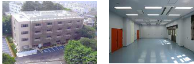
■ 千葉大亥鼻イノベーションプラザ(インキュベーション施設) (千葉市中央区亥鼻1-8-15 千葉大学亥鼻キャンパス内)
