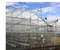
③ 自動開閉システム
