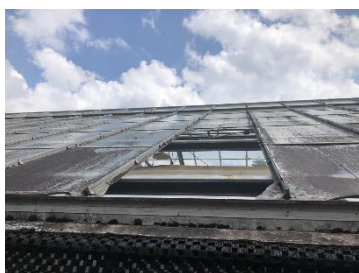
図19 ハウス等施設の老朽化(天窓等が破損し、未利用のままとなっています)
