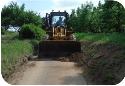
ショベルで土砂の 撤去
