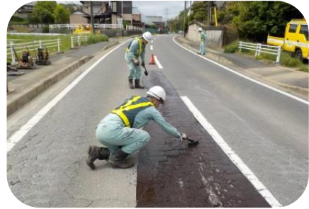
安全を確保して乳剤を塗る
