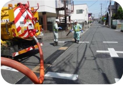
吹上防止のシート設置
