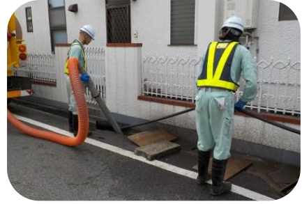
高圧洗浄車で土砂を引っ張る
