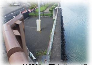
神明第一雨水ポンプ場
