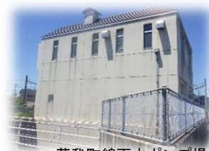
蘇我町線雨水ポンプ場
