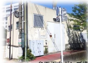
弁天雨水ポンプ場
