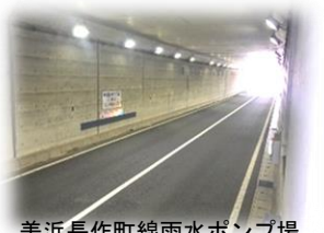
美浜長作町線雨水ポンプ場
