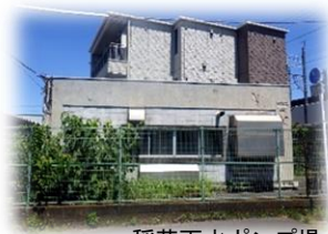
稲荷雨水ポンプ場
