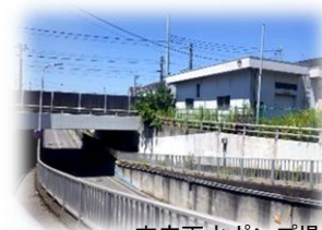
末広雨水ポンプ場
