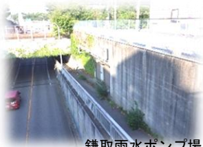
鎌取雨水ポンプ場
