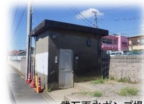
武石雨水ポンプ場
