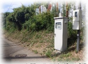
小間子町雨水ポンプ場
