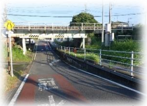
村田町道路排水ポンプ場
