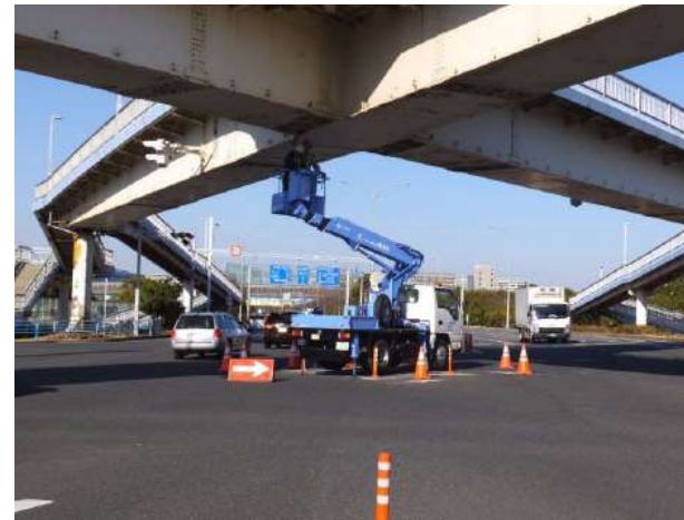
定期点検（近接目視）
