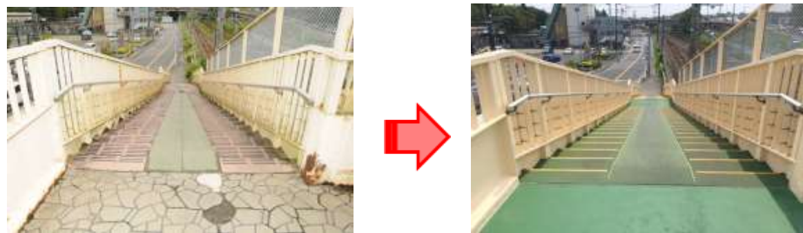
塗替え塗装・橋面補修（誉田歩道橋）
