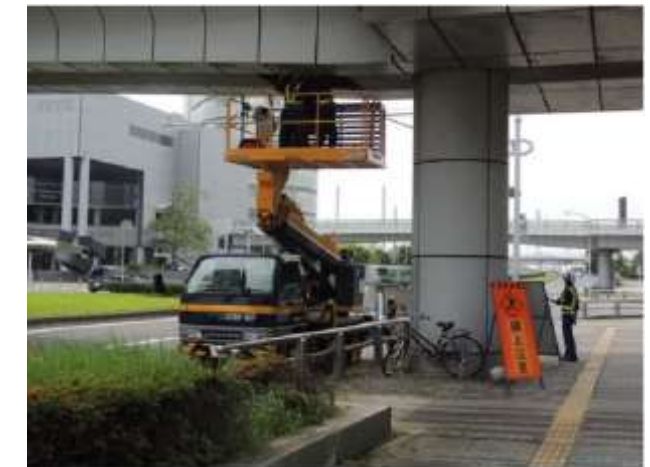
定期点検（近接目視）
