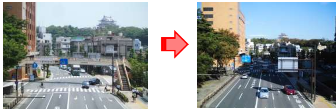
撤去工事（市場歩道橋）
