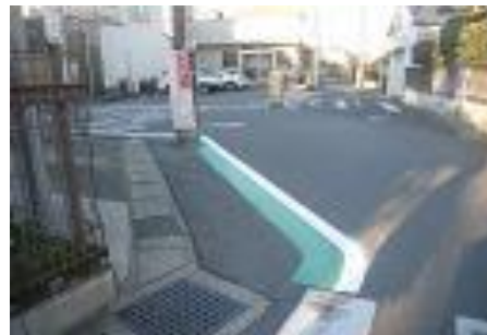
路肩のカラー舗装化で歩行者溜まりを確保した事例
