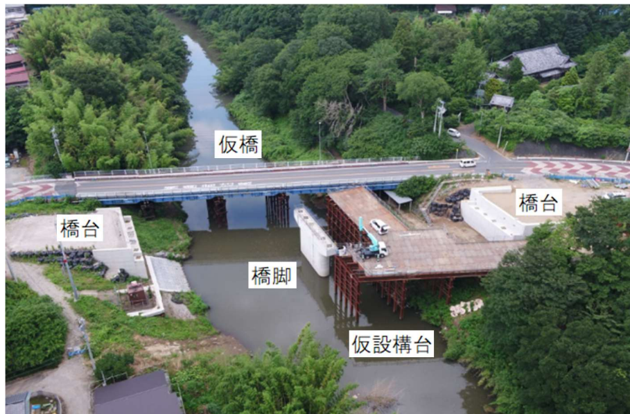
新橋下部工完成
