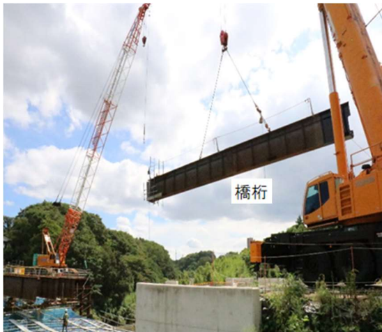
橋桁の架設状況
