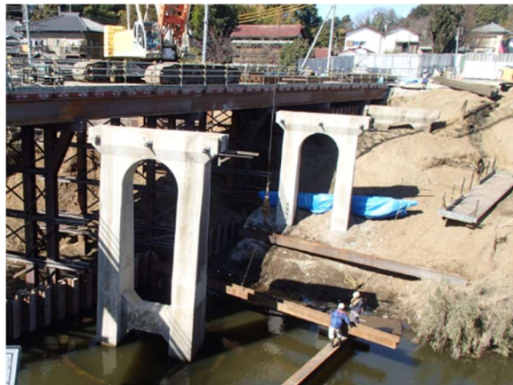
橋桁撤去完了
