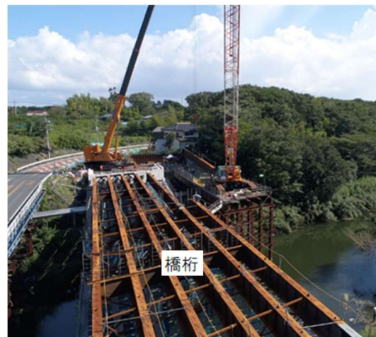
橋桁の架設状況
