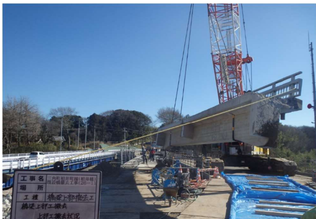
旧橋の撤去状況
